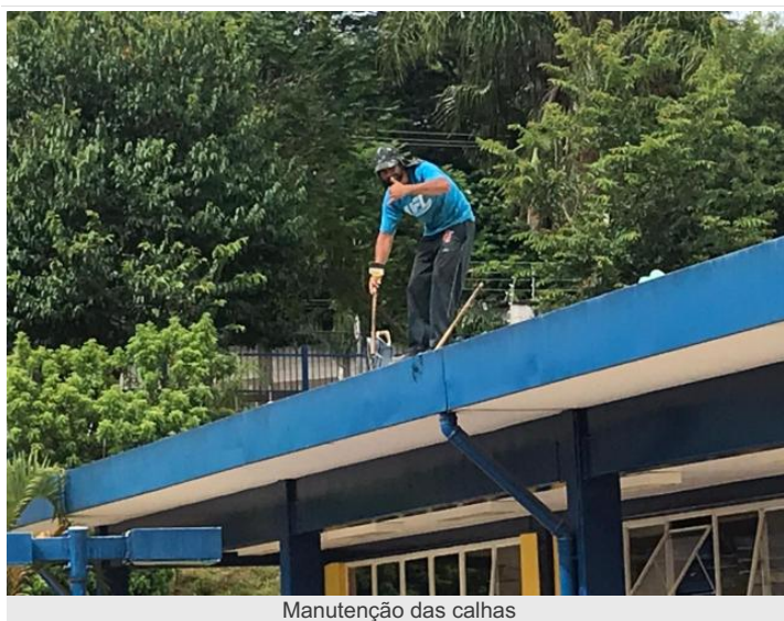
Manutenção das calhas
