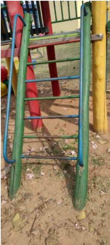
Manutenção da casinha do parque.
