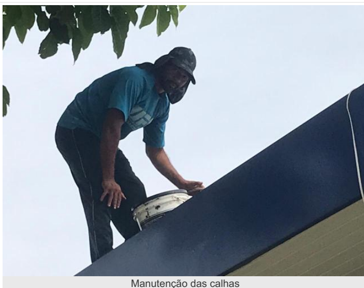
Manutenção das calhas
