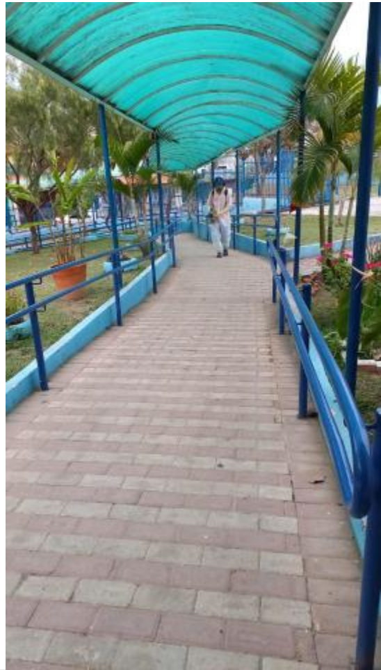
Sanitização da unidade escolar.
